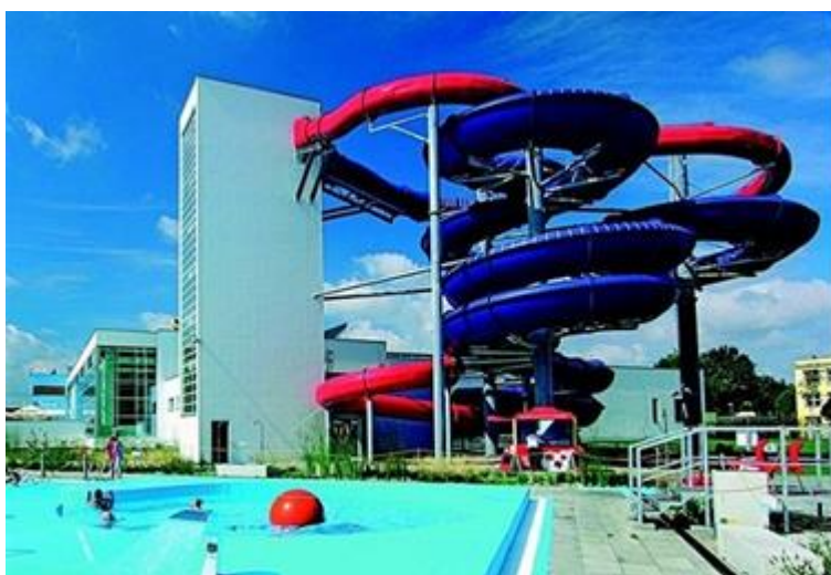
Obrázek 25 – Aquapark Uherské Hradiště – tobogany (zdroj: https://www.aquapark-uh.cz/ )
