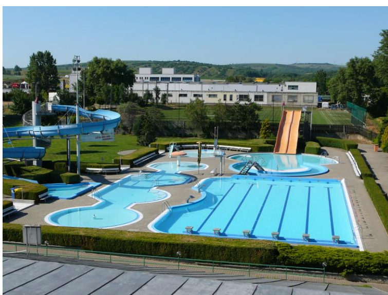
Obrázek 34 - Areál koupaliště a krytého bazénu Hustopeče – pohled na letní koupaliště (zdroj: www.google.com )
