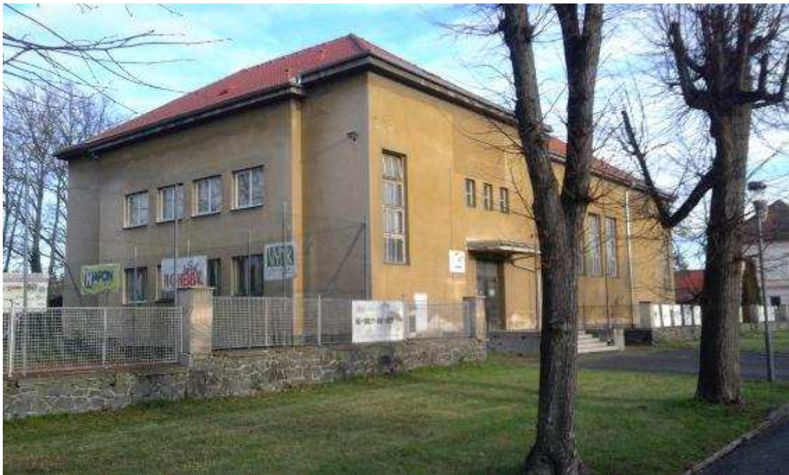
Obr. 2 - Snímek objektu v řešené části I – pohled z ulice
