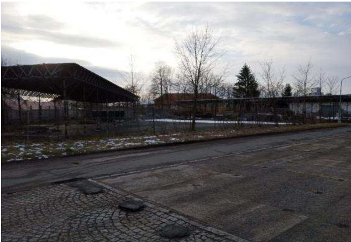
Obr. 4 - Snímek objektu v řešené části II
