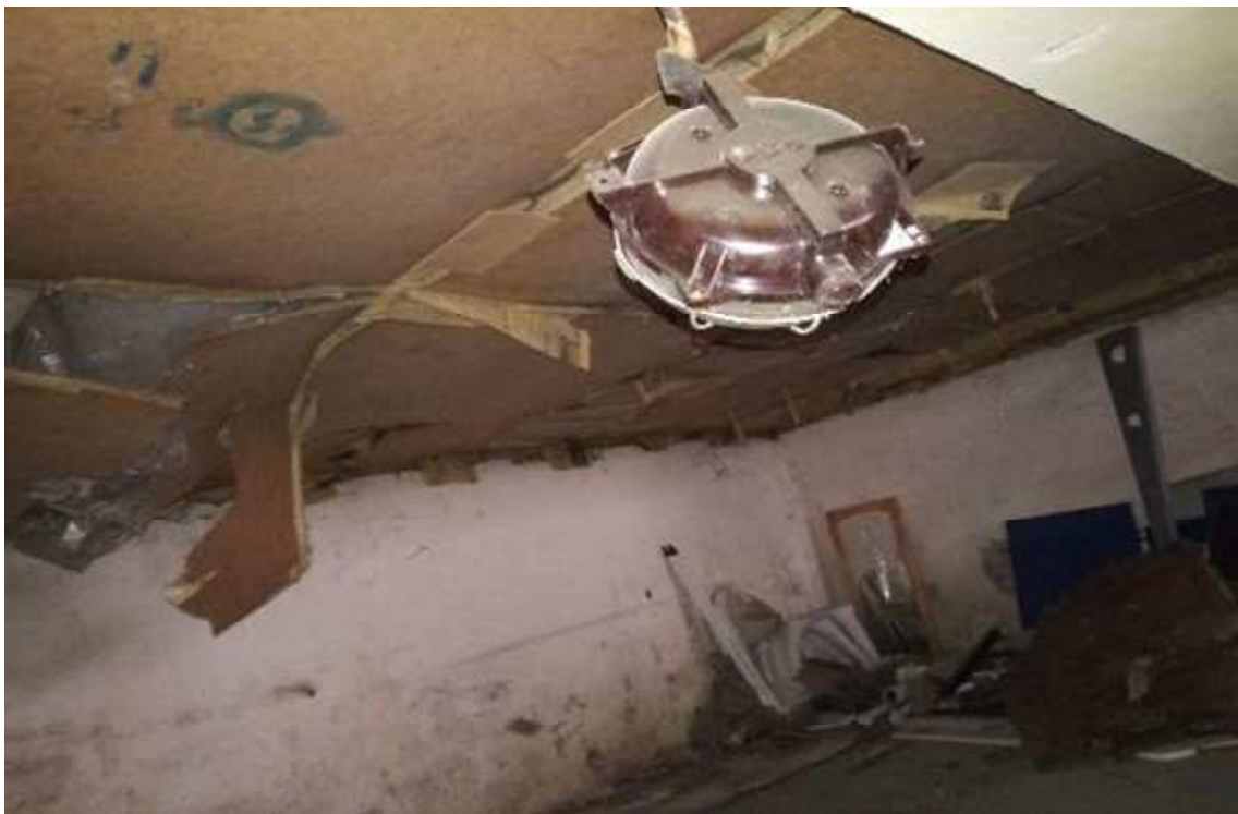
Obr. 7 - Snímek vnitřních prostor Sokolovny
