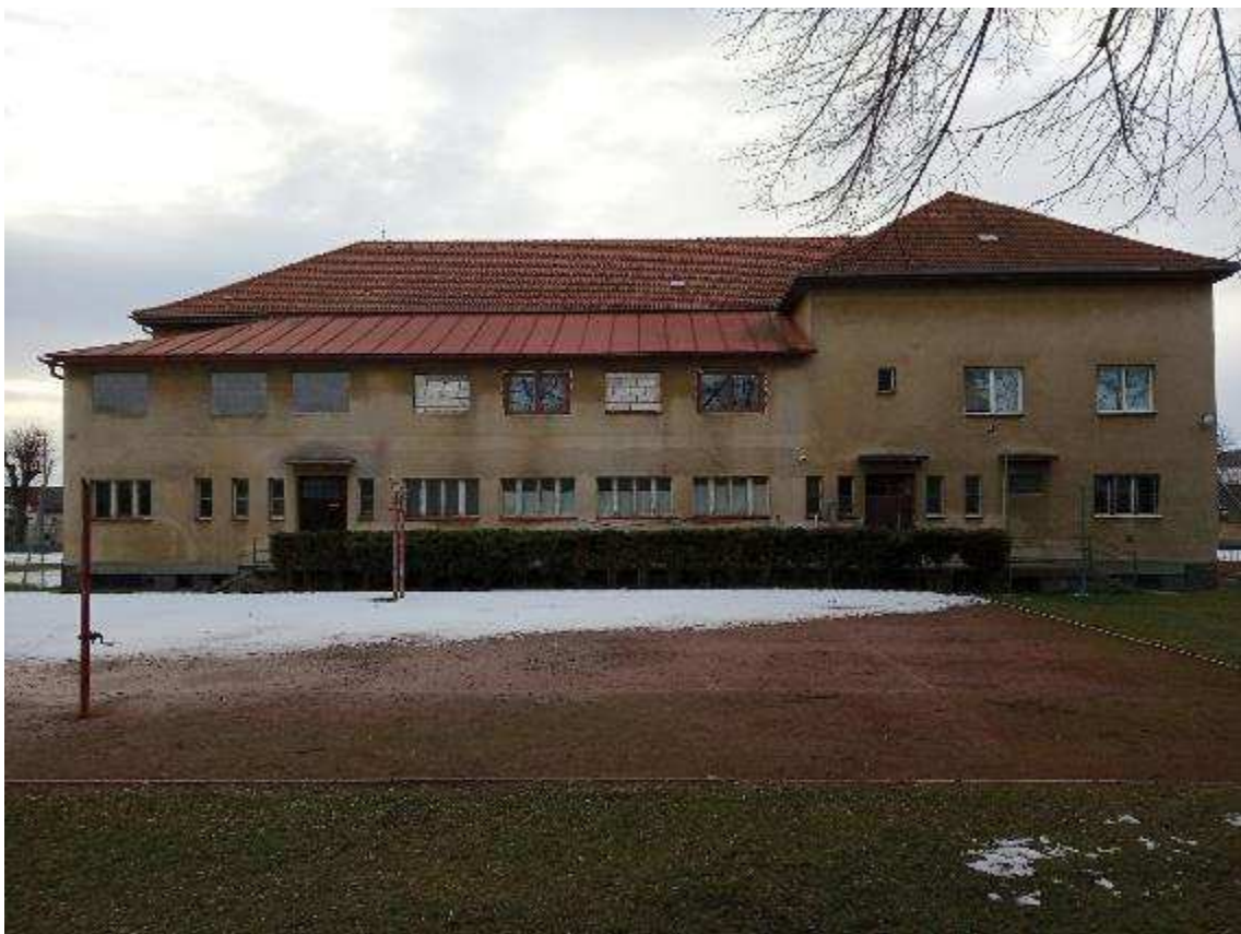
Obr. 3 - Snímek objektu v řešené části I- pohled ze zahrady
