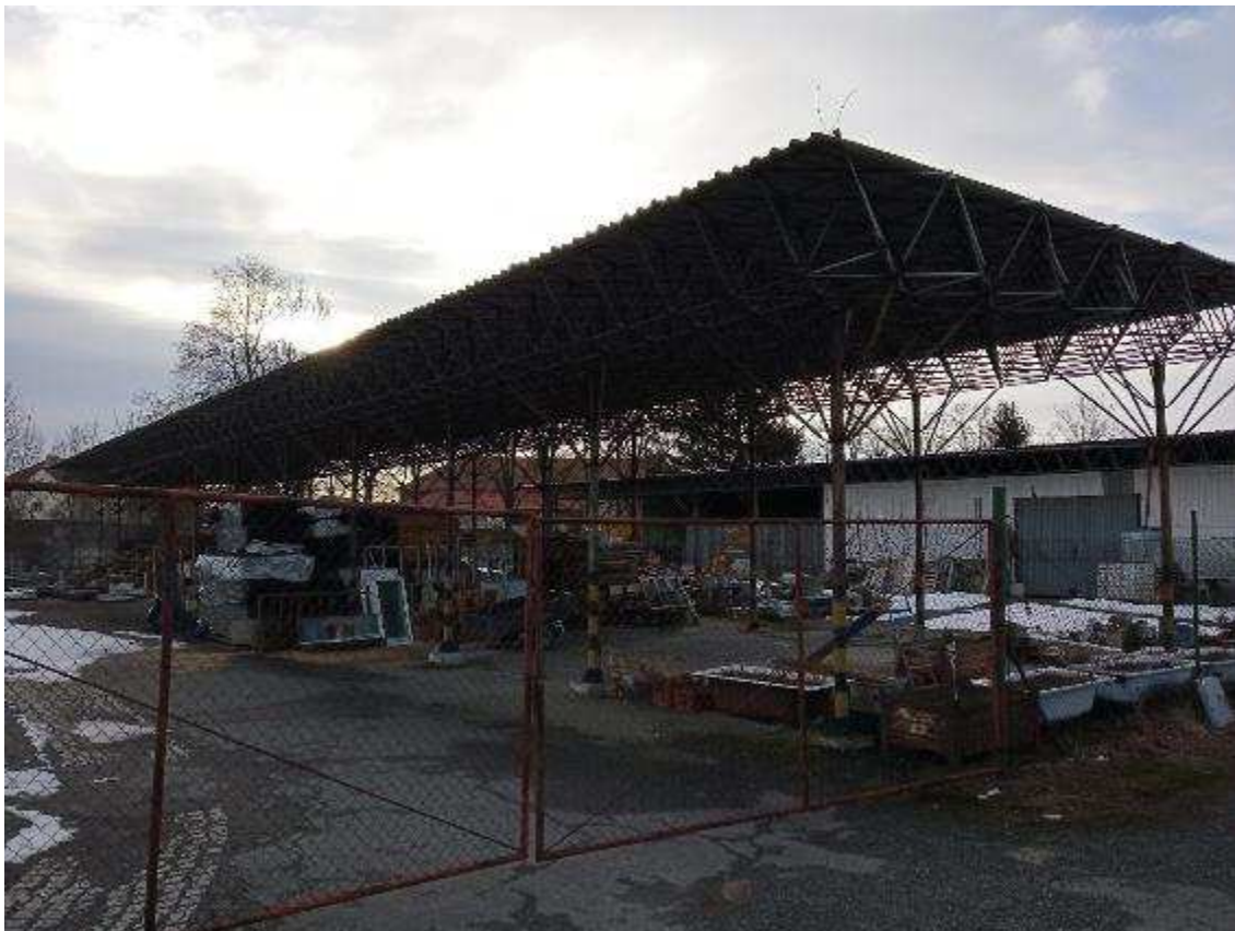
Obr. 12 - Snímek zpevněná plocha
